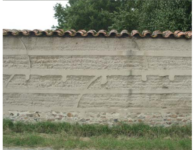
Mur en pisé
