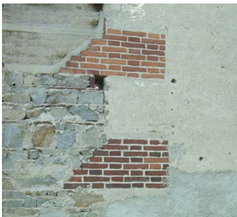
Chainage de liaison entre pisé et pierre en brique.
